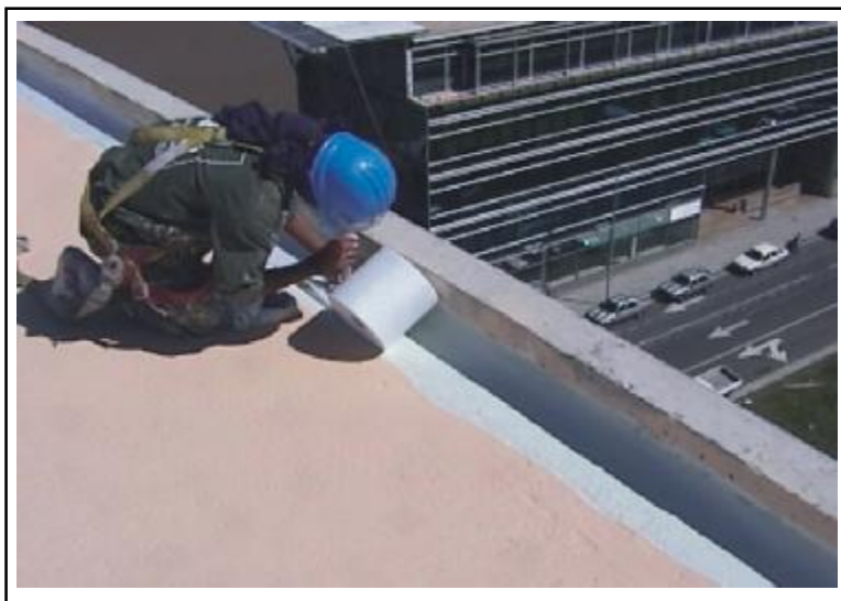
Colocacion con APR-1 Color Plus
