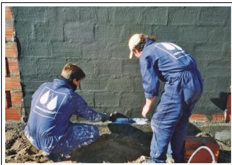
Colocacion con Dark Seal Plus
