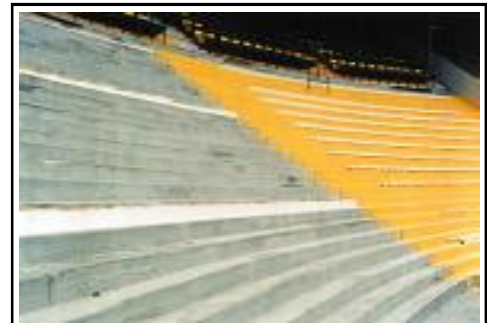
Remodelación Estadio Boca Juniors. Aplicación de ColorSEAL® PLUS Amarillo en Sector D.
