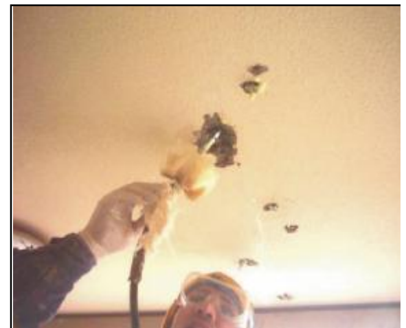
Inyección de poliuretano hidrofóbico hidroexpansivo
