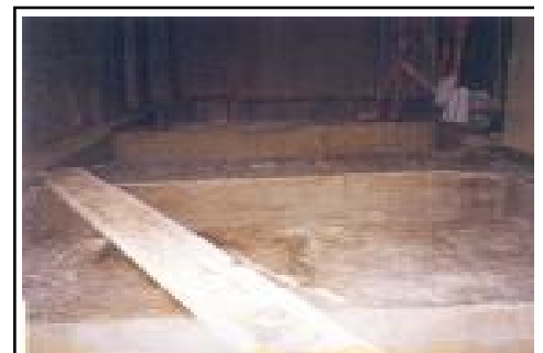
Obra Ortega y Gasset: Estudio Ianuzzi y Colombo Empresa Constructora: Bertoncini S.A. Subsuelo impermeabilizado con HidroSEC® .
