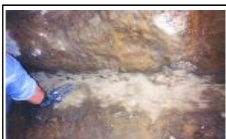
Frotado de la superficie con Componente Nº 2 de HidroSEC®
