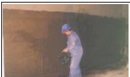
Aplicación Líquido Cristalizador penetración en los capilares del hormigon.
