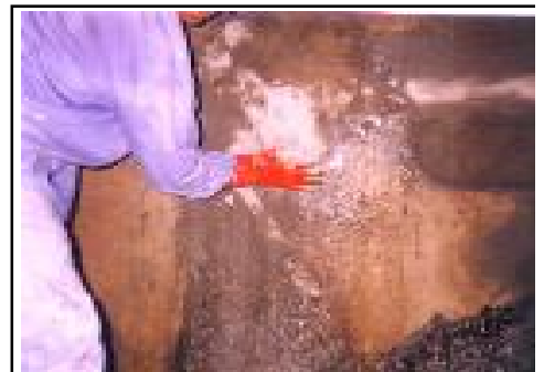
Frotado sobre taponamiento con componente N° de HidroSEC® .
