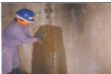
Recuperación de junta con Componente Nº 2
