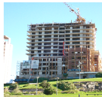
Obra: Aplicación bajo revestimientos, Edificio Tourbillón, Mar del Plata
