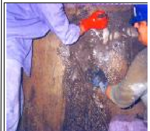
Ejecución del taponamiento con Sea/PLUG PLUS ®
