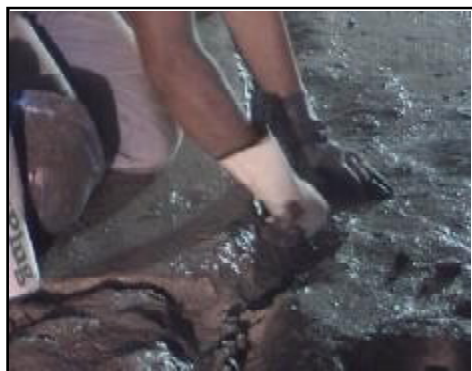
Taponamiento de juntas con Seal/PLUG PLUS ® Obra Torre de los colonos Puerto Madero.
