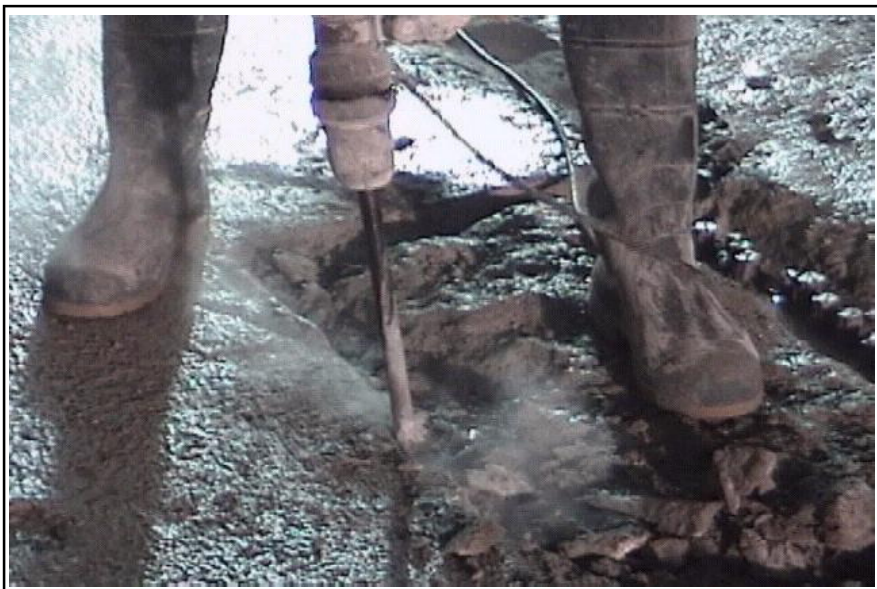
Apertura de juntas con martillo electromecánico en losa de subpresión
