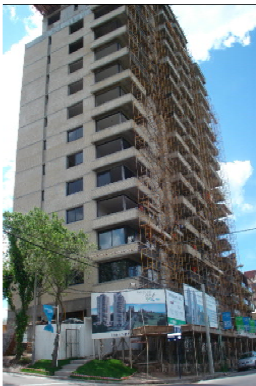
Obra: Torres del Golf, Mar del Plata. Coarco S.A.
