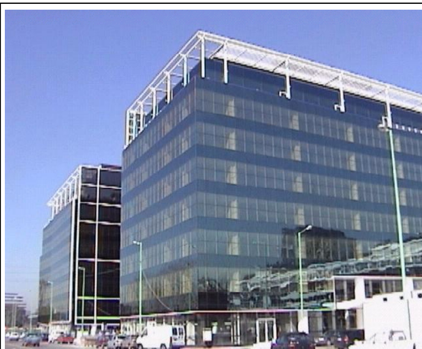
Obra Torre de los Colonos -Puerto Madero 9000 m2
