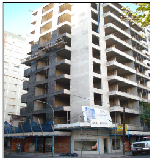
Obra: Edificio Sol Plaza, Mar del Plata Constructora NES S.A.
