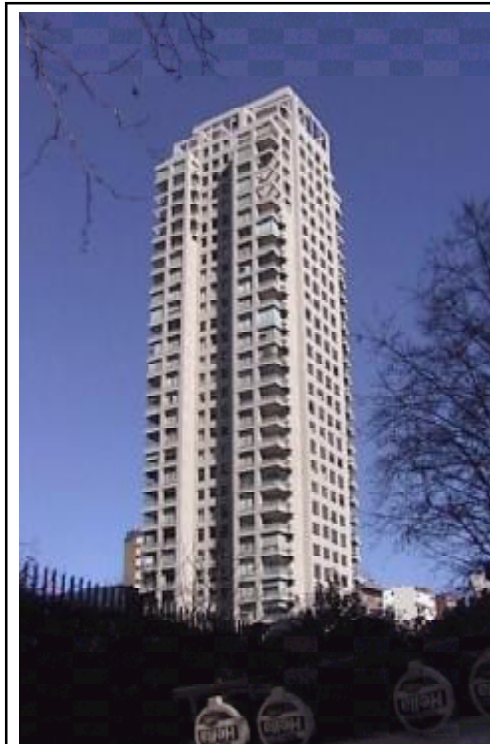
Obra: Quartier Oro 5200 m2
