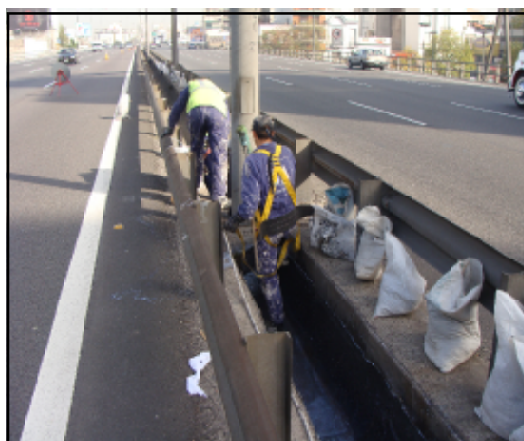
Autopistas Urbanas S.A.
